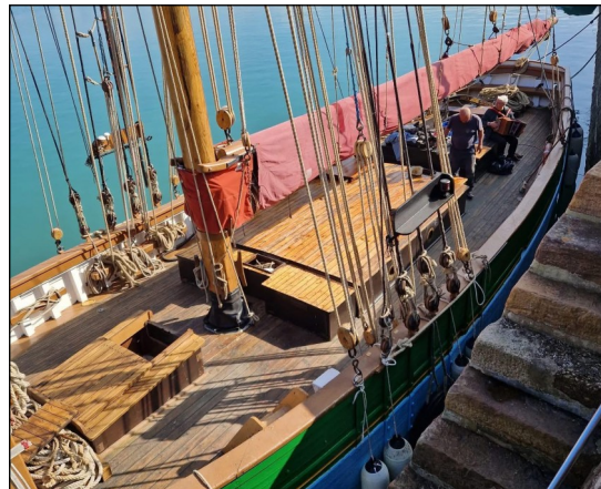
Rénovation des roofs et entretien du pont
